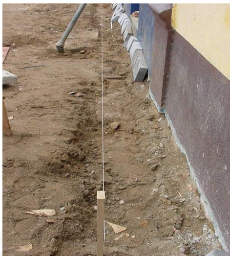
Controle do caimento e da espessura
