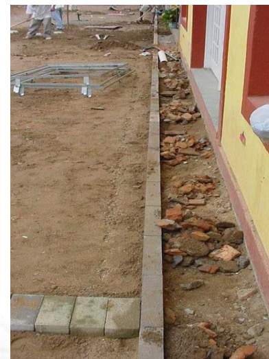
Alinhamento e nivelamento
